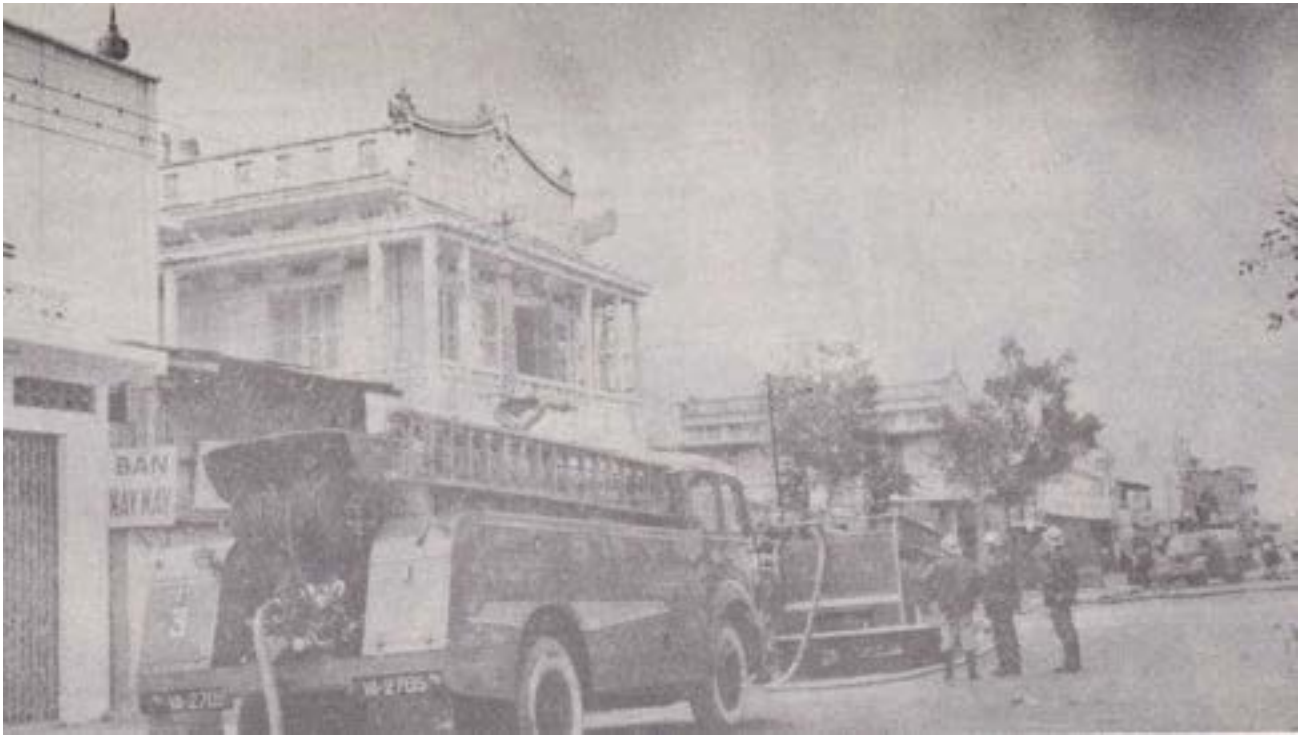
Khu chùa Ấn-Quang cháy ngày 1/2/1968 lính cứu hỏa đô-thành đang chữa lửa
