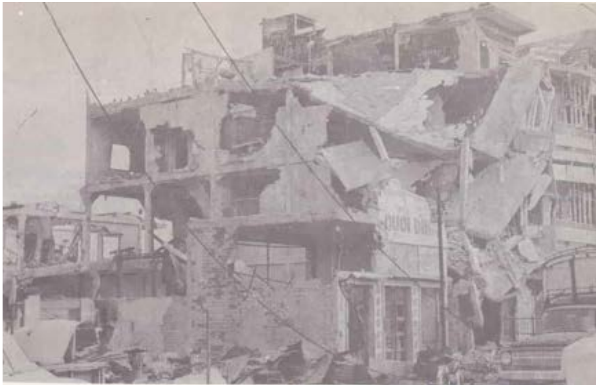
Cảnh đổ nát tại đường Minh-Phụng nơi đây địch đặt một ổ kháng cự mạnh
