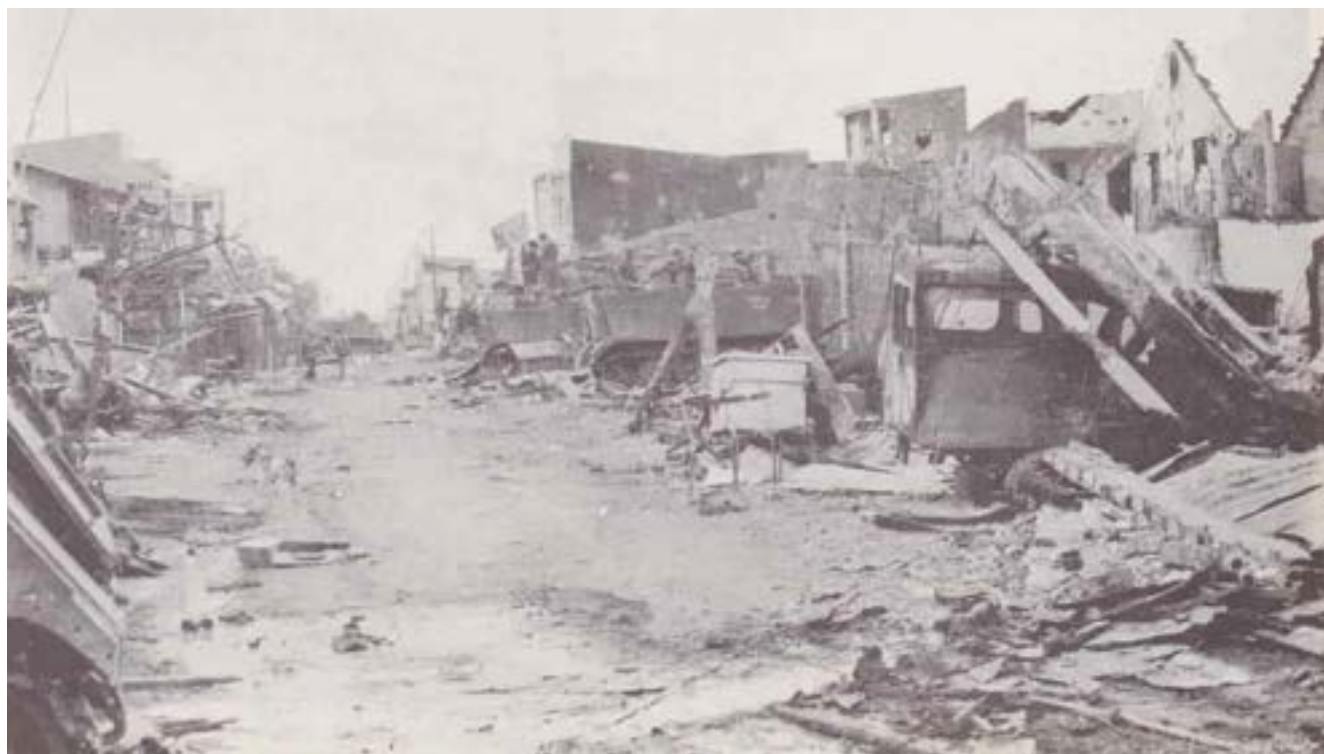
Cảnh đổ nát của khu chợ Phạm-Thế-Hiển sau biến cố
