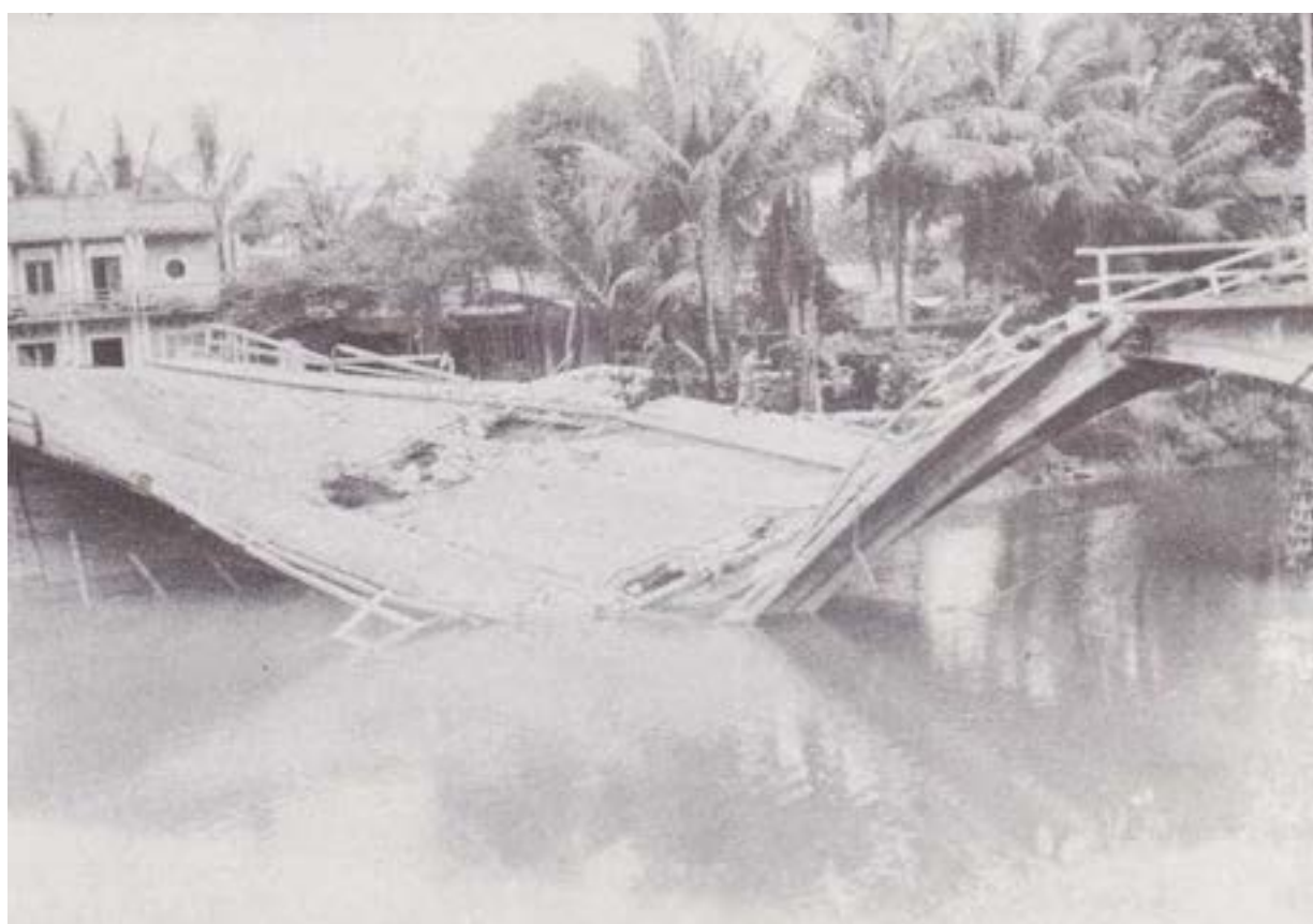
Cầu Phú-Cam bị sập, phải phá đi xây lại. Hình ảnh nhìn thẳng và nhìn ngang
