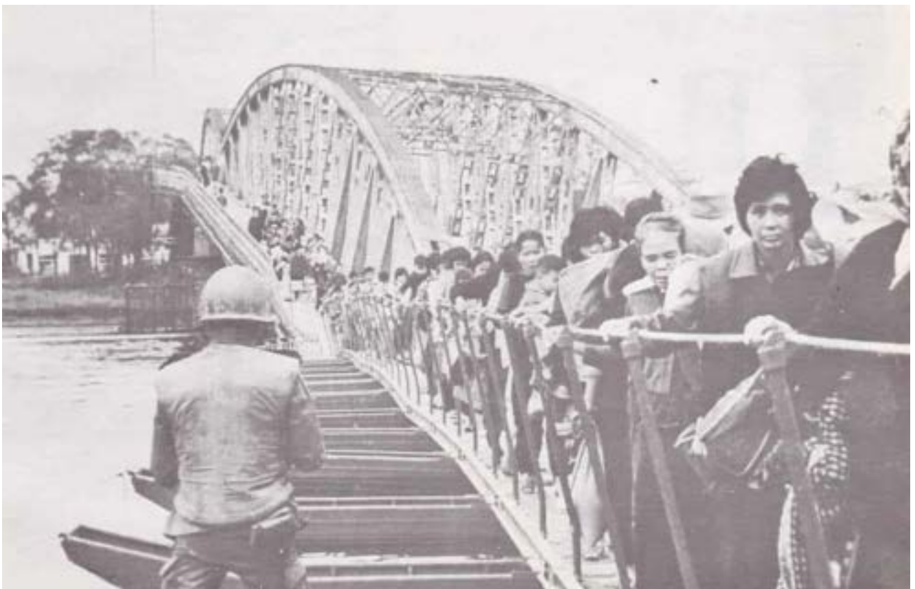
Tại chỗ cầu gãy, Công-binh làm hai nhịp cầu nhỏ cho bộ hành
