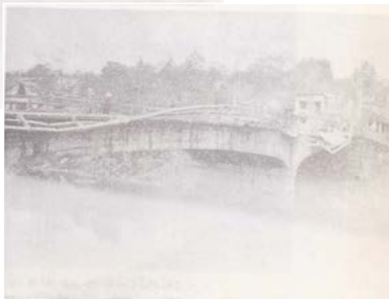
Cầu Bến-Ngự bị hư nhẹ Hình ảnh nhìn thẳng và nhìn ngang
