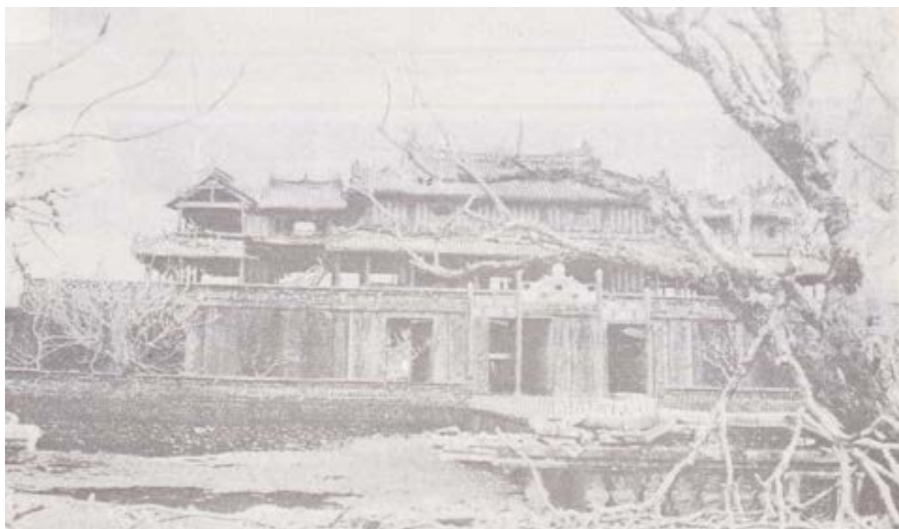
Cửa Ngọ-Môn chụp từ sân điện Thái-Hòa
