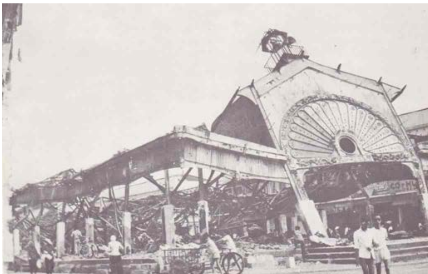
Chợ Kiến-Hòa bị cháy rụi trong biến cố Tết Mậu-Thân
