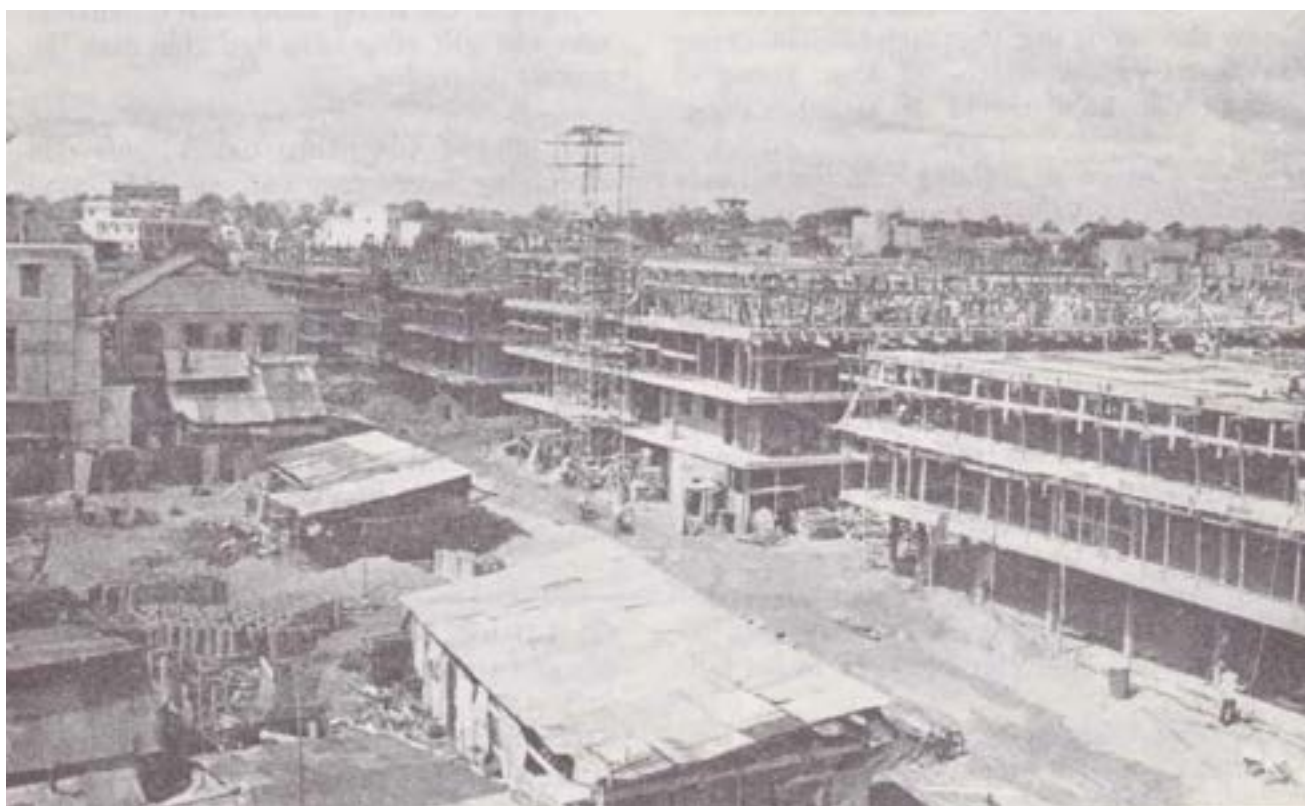
Các căn nhà bị cháy trong dịp biến cố đã được thay thế bằng những chung-cư đầy tiện nghi và ánh sáng dành cho các nạn nhân chiến cuộc. Hình chụp khu chung cư Su-Vạn-Hạnh Sài Gòn đang xây cất.
